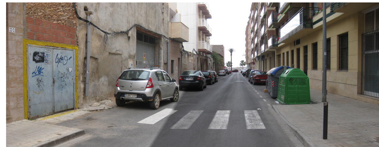
Imagen 107: Paso peatonal carrer del Comerç. Inexistencia de vado ni pavimento señalizador. Fuente: Propia.
