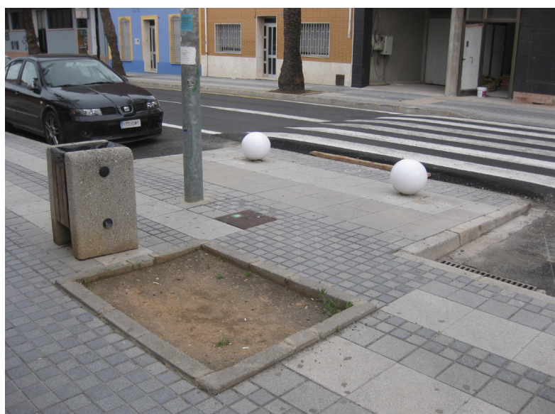
Imagen 67: Bolardos inaccesibles y alcorque descubierto. Fuente: Propia.
