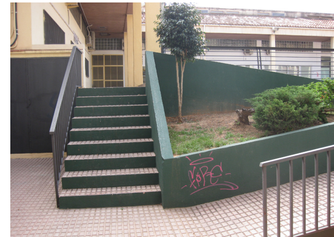
Imagen 23: Escalera con barandilla inadecuada. Fuente: Propia
