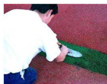
Imagen 2.8 Aplicación "in situ" del pavimento de caucho.
