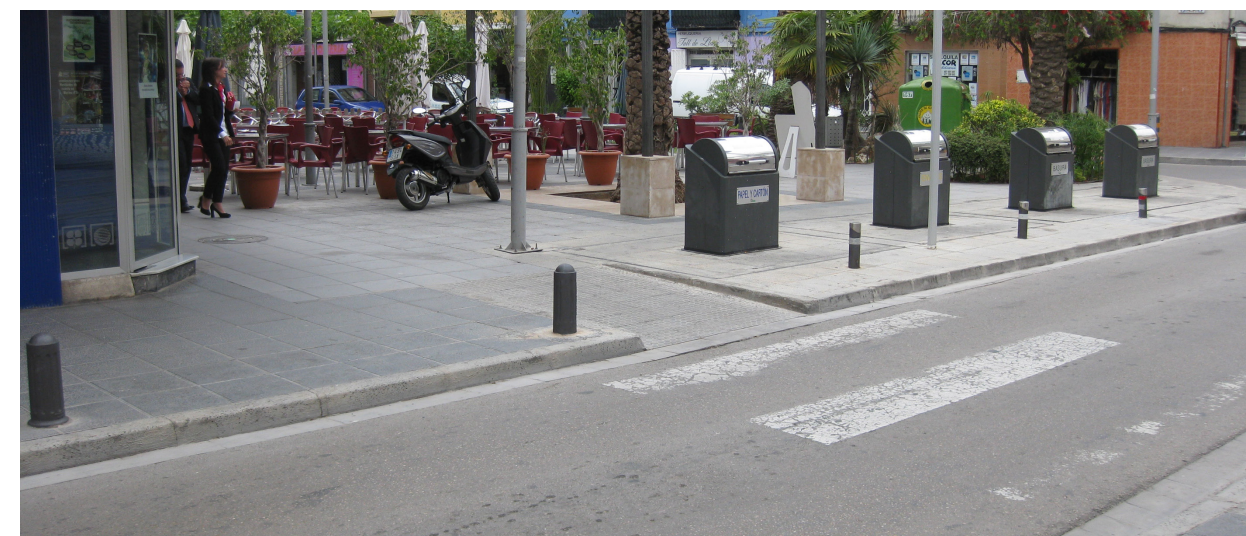
Imagen 113: Vado peatonal estrecho sin pavimento señalizador y con bordillo en Plaça del Mercat Vell. Fuente: Propia
