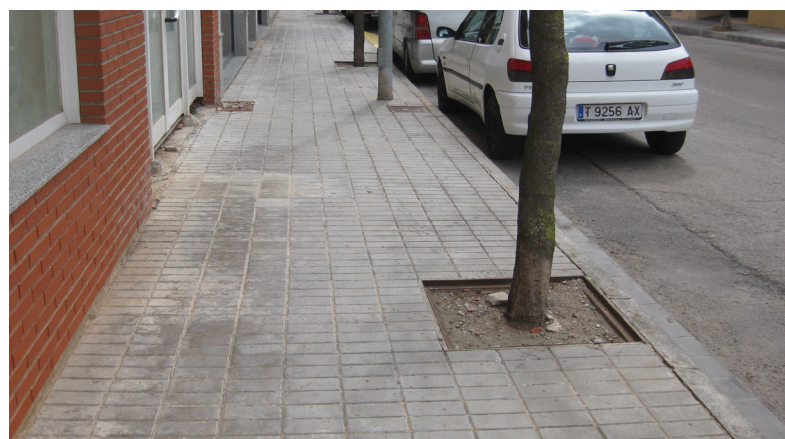
Imagen 96: Alcorque sin rejilla y enrasado en itinerario. Fuente: Propia
