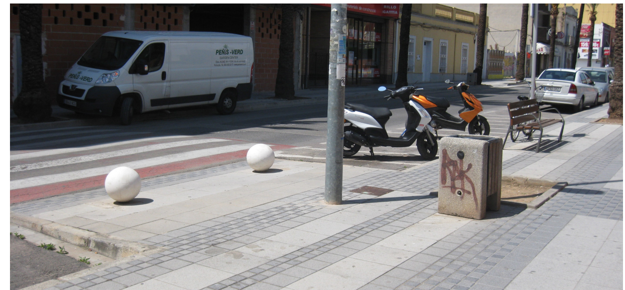
Imagen 66: Mobiliario mal colocado en paso peatonal Passeig marítim nº 62. Bolardos no accesibles. Fuente: Propia.
