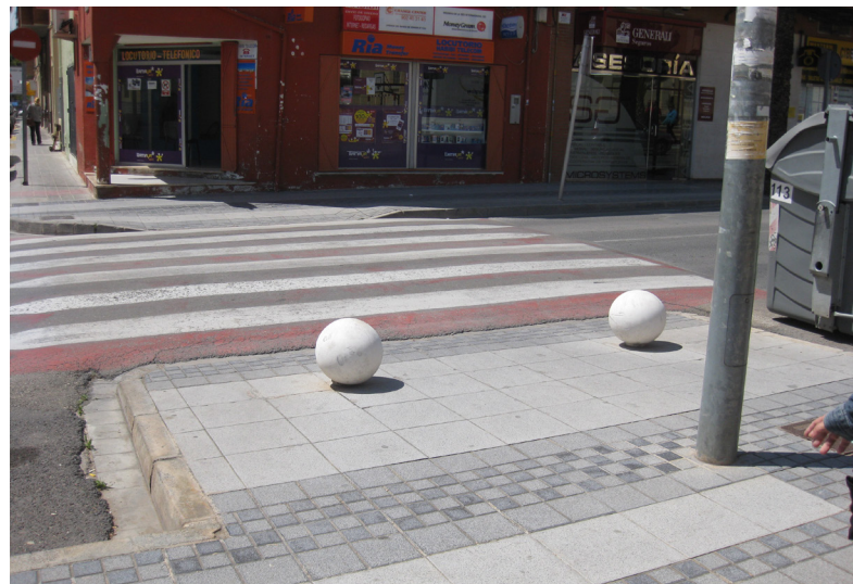
Imagen 26: Bolardos en inadecuada posición
