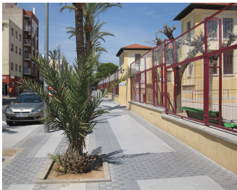
Imagen 68: Alcorque descubierto Passeig Marítim. Fuente: Propia.
