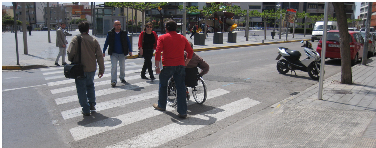
Imagen 22: Vado sin franja abotonada. Paso de peatones pintado en diagonal en plaza Constitución. Fuente: Propia.
