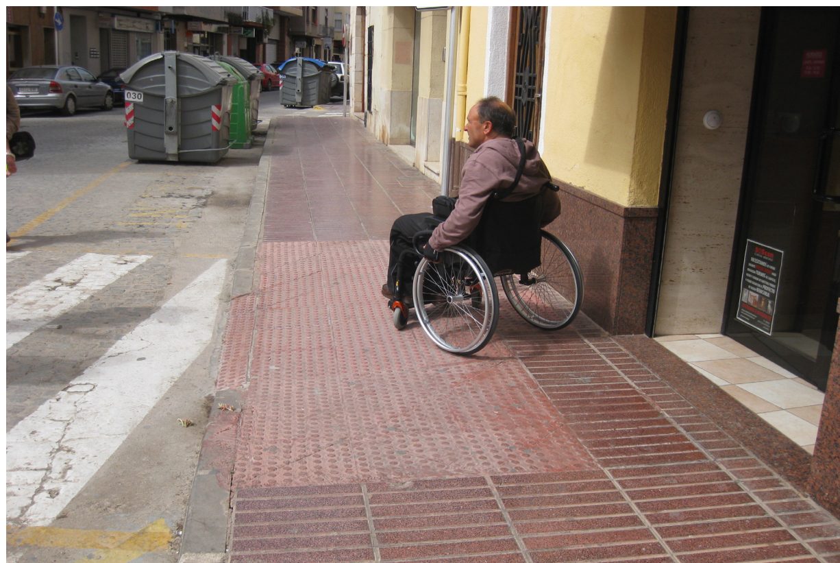
Imagen 18: Vado peatonal en la C/ Alcalá de Xibert invadiendo el ancho libre de paso de l itinerario peatonal.
