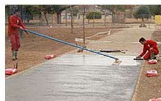
Imagen 2.3. Extendido del hormigón
