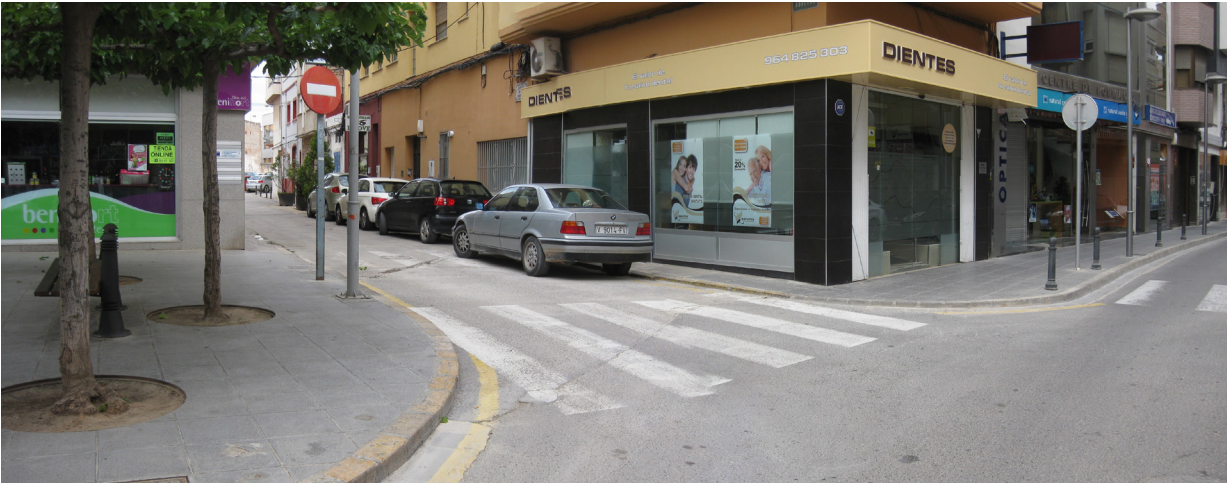
Imagen 103: Paso peatonal cruce Crist de la Mar con carrer de les Moreres. Inexistencia de vado. Fuente:Propial.
