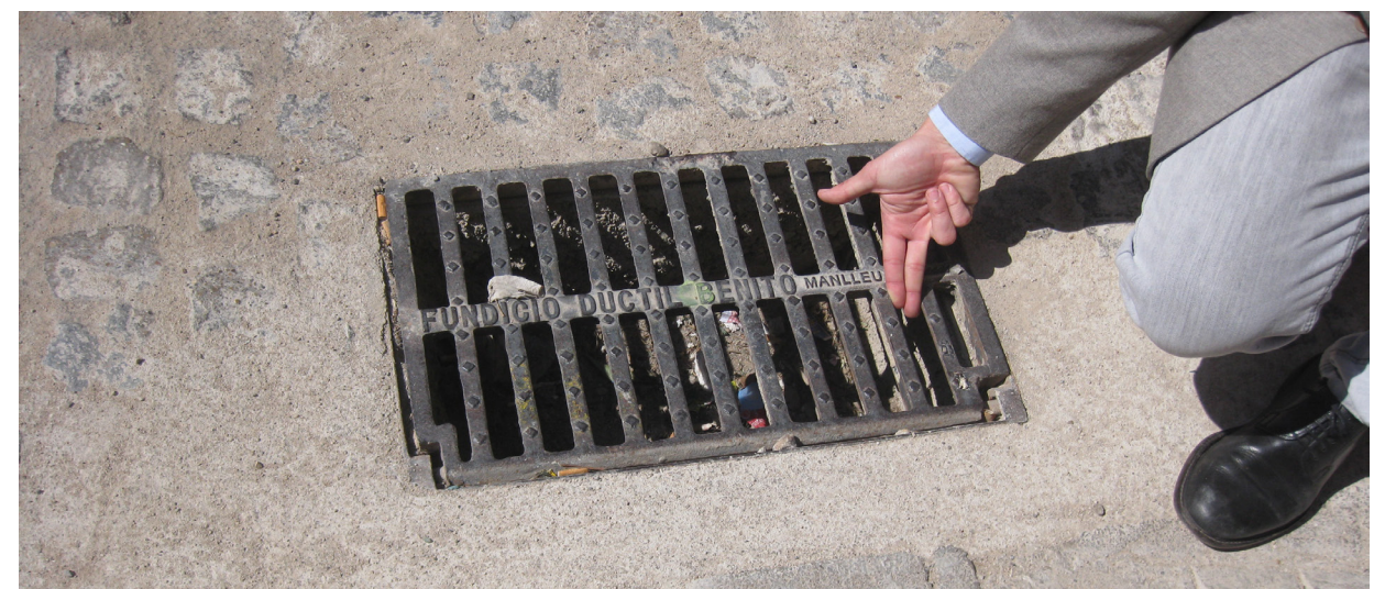
Imagen 21: Reja de alcantarillado con ancho superior a 2 cm. Fuente: Propia
