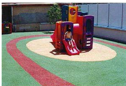
Imagen 2.7. Estado final del pavimento de caucho continuo recubriendo parques infantiles.
