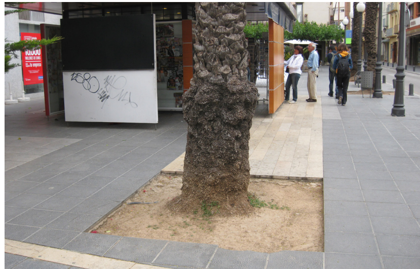
Imagen 114: Alcorque sin rejilla y sin bordillo enrasado en itinerario peatonal ubicado en la Plaça del Mercat Vell. Fuente: Propia.
