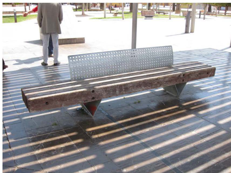
Imagen 1.4: Plaza de la Constitució banco con parte del asiento volado y sin prolongación vertical, problema de tropiezo para invidentes y otros usuarios.
