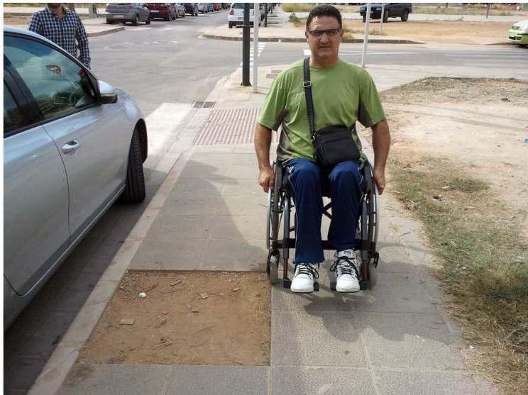
Imagen 1.2: Alcorques mal ubicados y sin rejilla protectora, limitan el ancho de paso útil.
