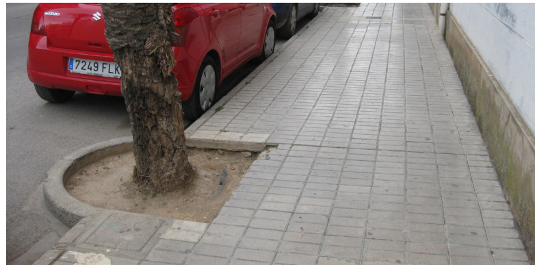
Imagen 94: Alcorque sin rejilla y enrasado en itinerario. Fuente: Propia
