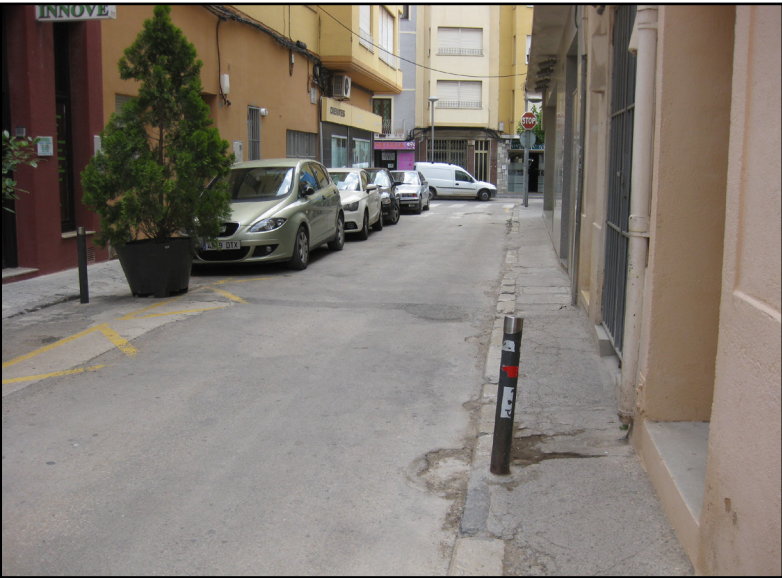
Imagen 102: Acera estrecha con pavimento en muy mal estado en carrer de les Moreres. Fuente: Propia.
