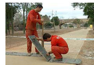
Imagen 2.5. Estampado del hormigón
