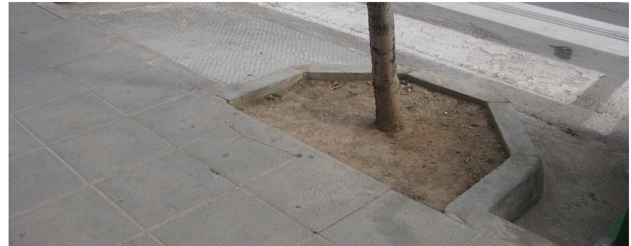
Imagen 20: Alcorque sin rejilla y enrasado al pavimento de la acera. Fuente: Propia.
