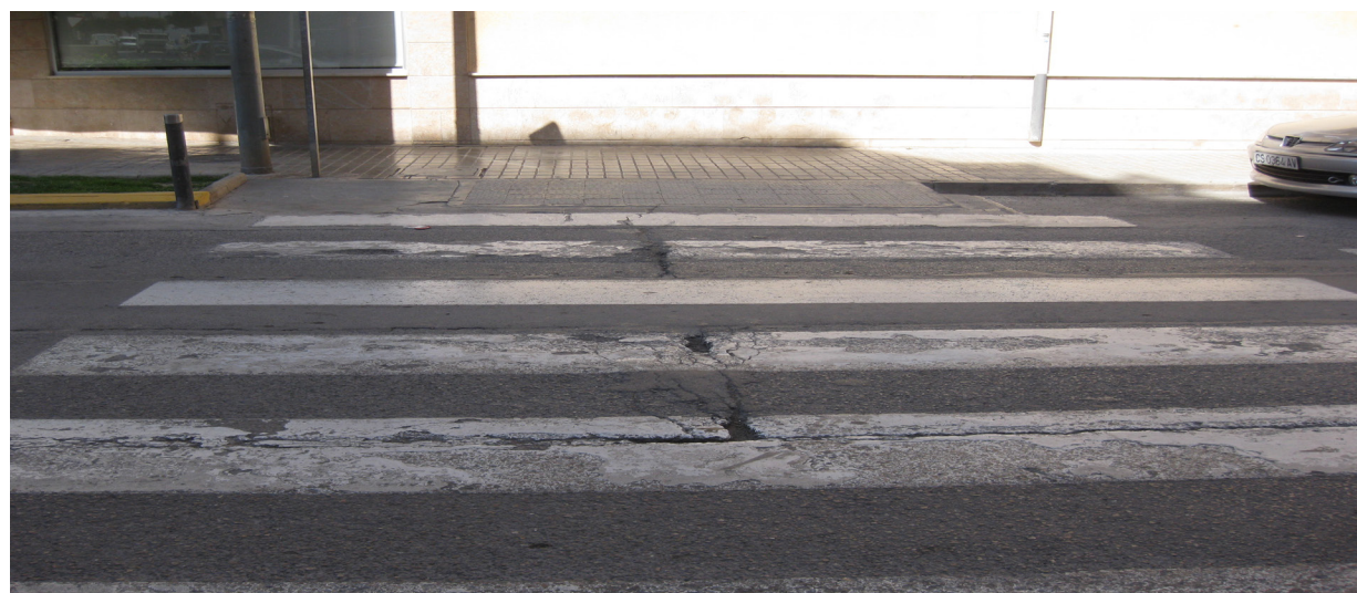
Imagen 19: Pavimento del paso peatonal en mal estado de conservación. Fuente: Propia.
