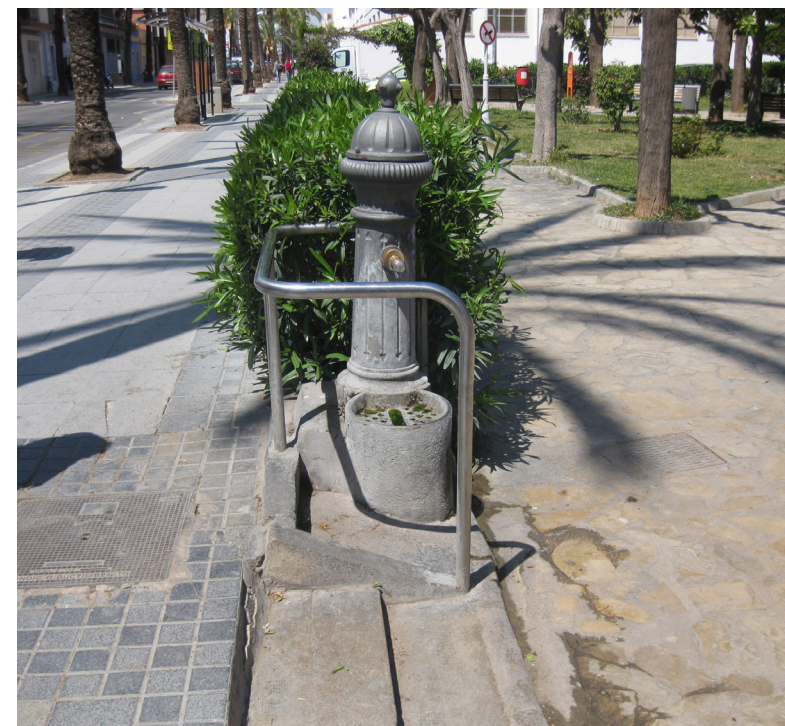
Imagen 30: Fuente inaccesible para una silla de ruedas
