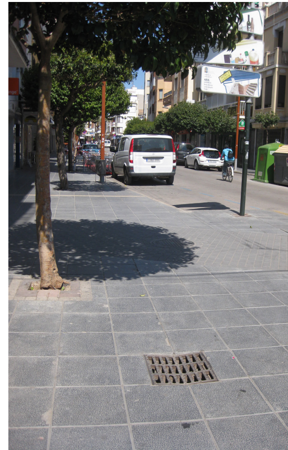
Imagen 116: Rejilla con anchura de huecos excesiva y orientada en sentido de la marcha.
