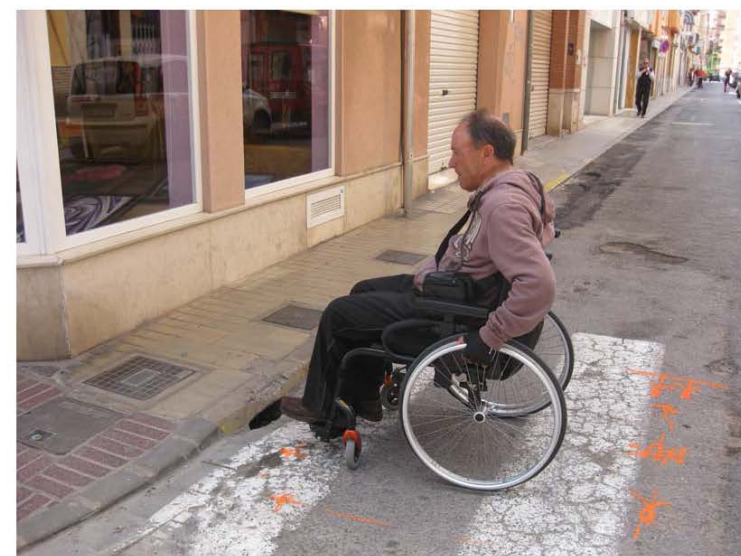
Imagen 1.1: Paso de peatones en las proximidades del Ayuntamiento. Se detecta una mala ejecución del paso de peatones, sin vado adecuado, sin señalización, con imbornal a mitad de éste, en junto a un pavimento en malas condiciones y una acera excesivamente estrecha para permitir la
