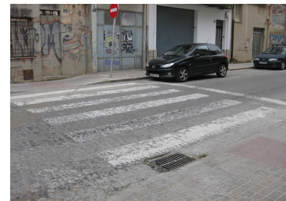
Imagen 98, 99 y 100: Señal de tráfico mal puesta en c/ Vinarós nº 5 (izquierda) y nº 73 (derecha arriba). Rejilla de recogida de aguas pluviales en paso peatonal C/ Vinarós nº 37. Fuente propia.
