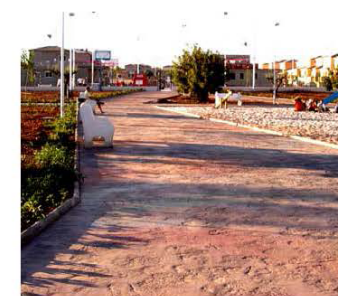
Imagen 2.2.: Estado final que presenta un vial realizado con hormigón impreso.
