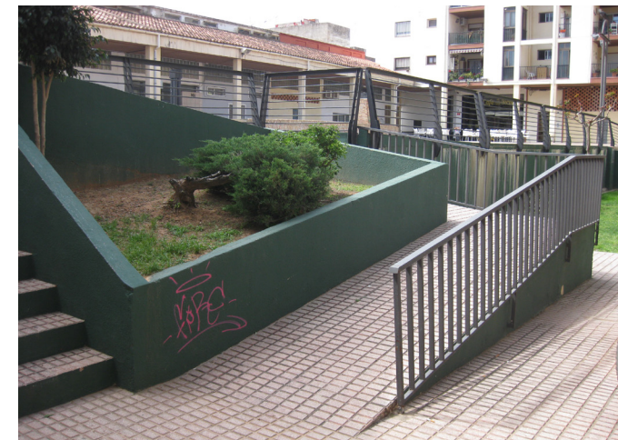
Imagen 24: Rampa con excesiva pendiente. Fuente: Propia
